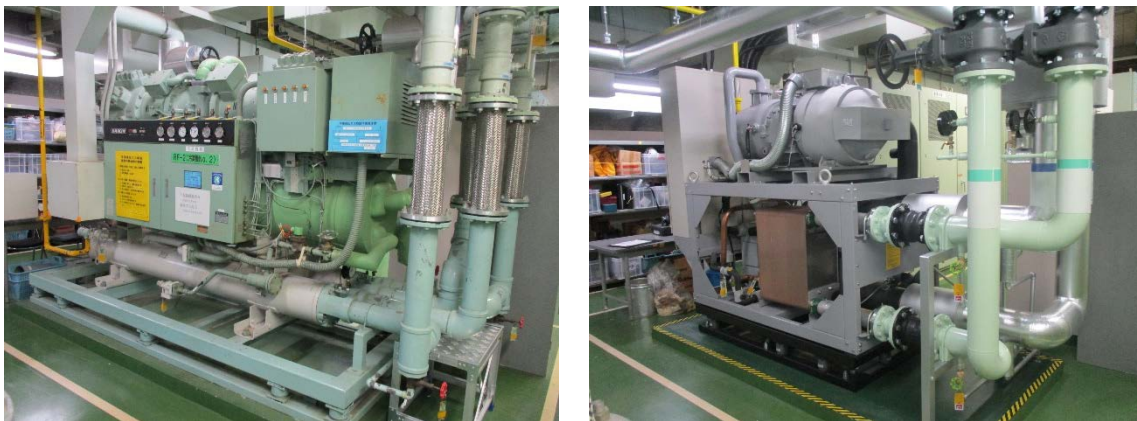
写真 2.1.7-1 冷凍機No.2 (左)旧、(右)新
