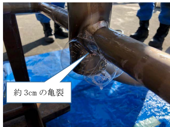
写真 2.8.2-2 気化管の漏えい検査状況
