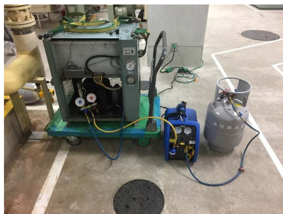
写真 2.1.9-2 撤去前のフロンガス回収
