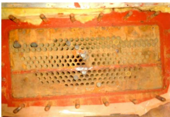
蒸発器プラグ処置実施前
