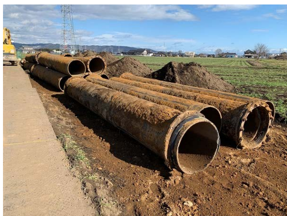
写真 2.10.5-1 導水管撤去状況
