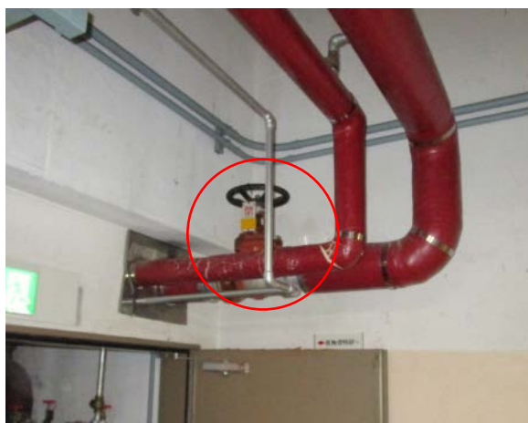
写真 2.1.11-1 主蒸気バルブ更新後
