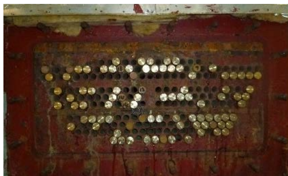
蒸発器プラグ処置実施後
