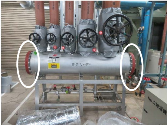
写真 2.1.3-1 保温材の取付け前
