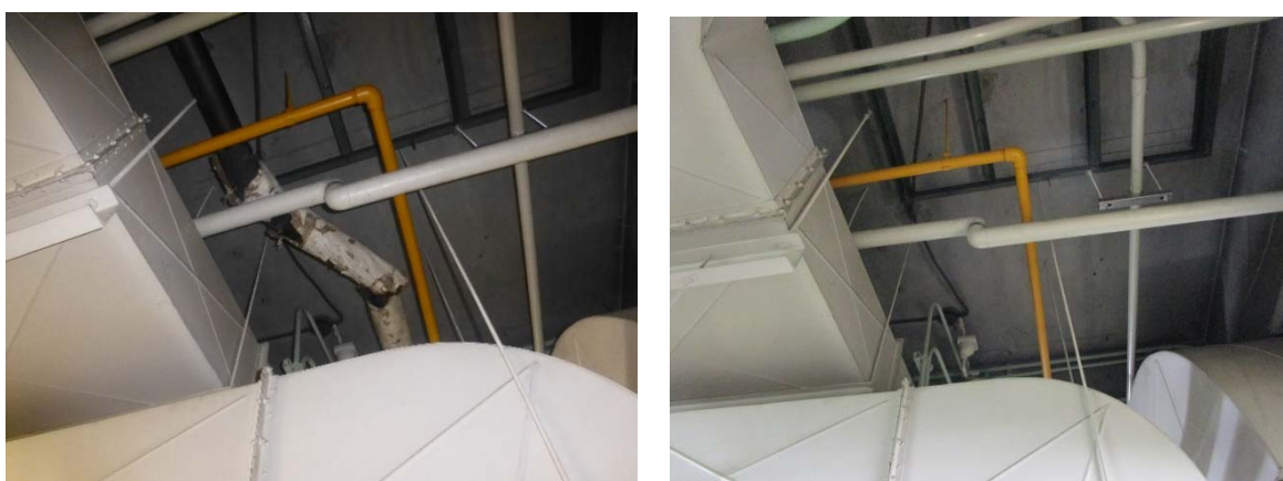
写真 2.1.11-2 排水配管の撤去前・撤去後
