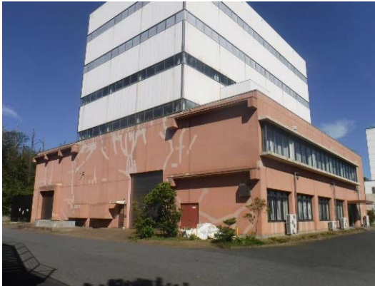
写真 2.10.1-3 大型再冠水実験棟 外壁塗装 改修前
