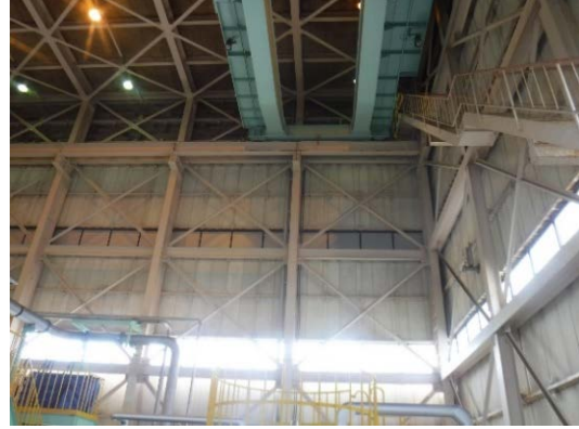
写真 2.10.1-2 大型再冠水実験棟 鉄骨ブレース改修 改修後
