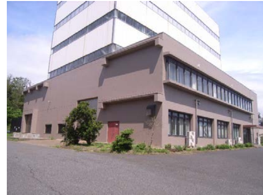
写真 2.10.1-4 大型再冠水実験棟 外壁塗装 改修後
