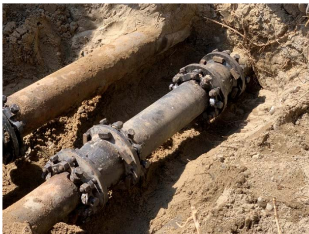
写真 2.1.20-1 汚染除去場東側工水管漏えい補修状況
