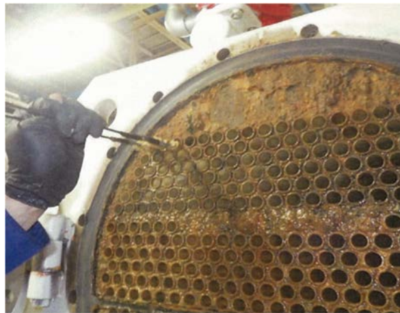
冷却管洗浄状況
