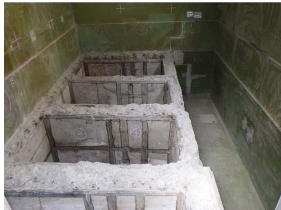
写真 2.10.4-2 廃液貯槽、廃液配管撤去後
