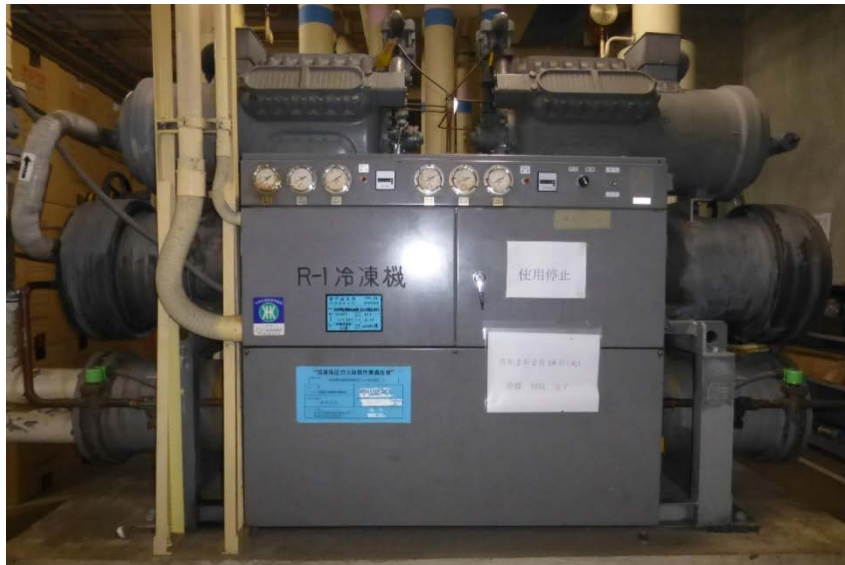
写真 2.1.15-1 レシプロ冷凍機
