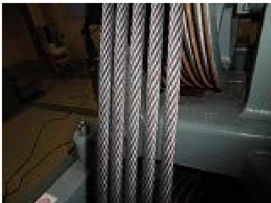
写真 2.10.2-1 減容処理棟 昇降機（荷物用）主ロープ 更新後
