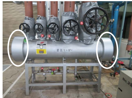
写真 2.1.3-2 保温材の取付け後
