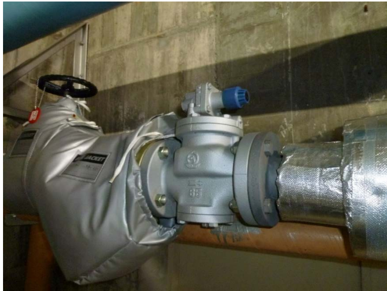
写真 2.1.14-1 減圧弁更新後
