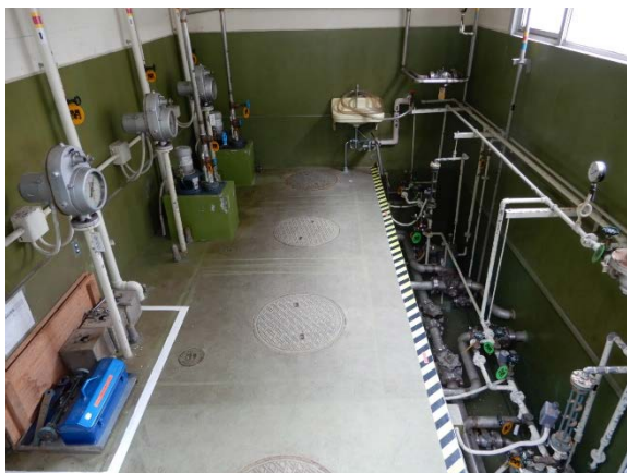
写真 2.10.4-1 廃液貯槽、廃液配管撤去前
